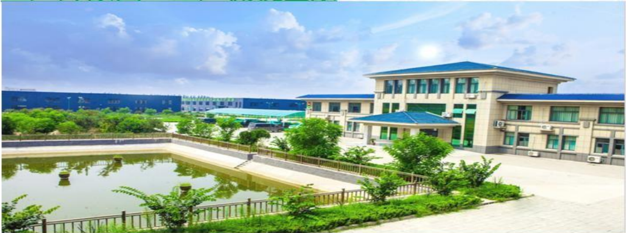
工厂外景图：工厂侧视全景
