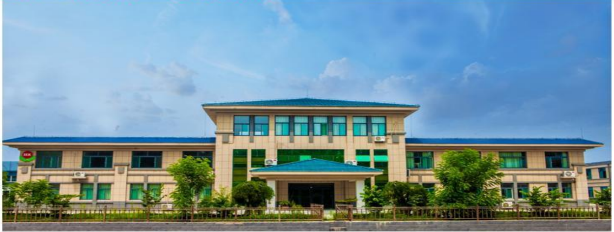
工厂外景图：办公大楼
